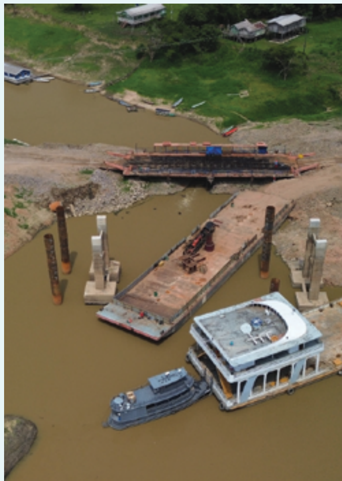
OBRAS DA PONTE SOBRE O RIO AUTAZ-MIRIM/AM
