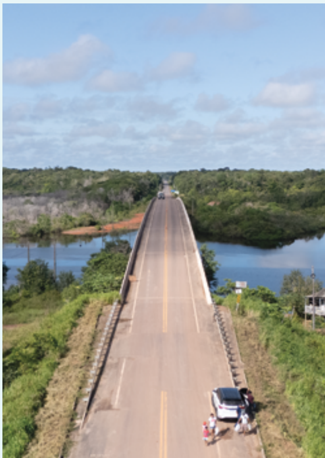
PONTE SOBRE O RIO TUPANA KM 177 DA BR-319/AM
