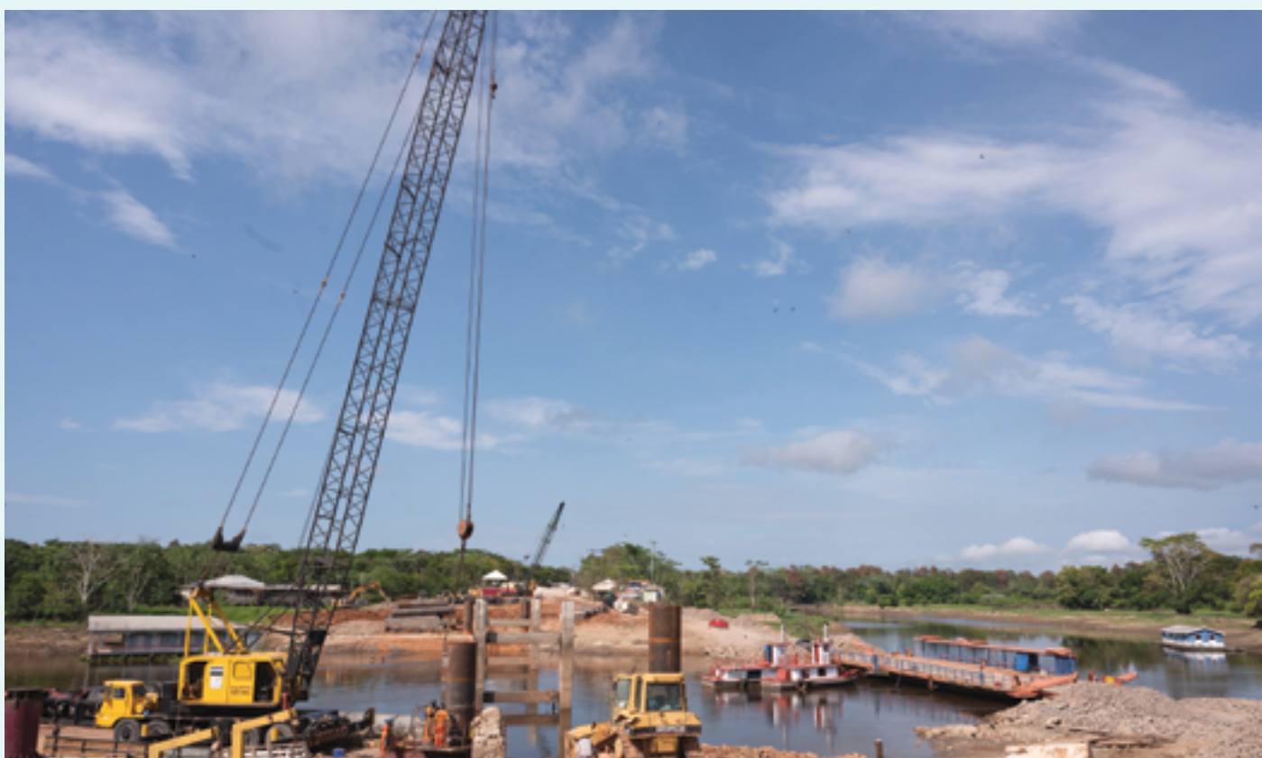
OBRAS DA PONTE SOBRE O RIO AUTAZ-MIRIM/AM - BR-319
