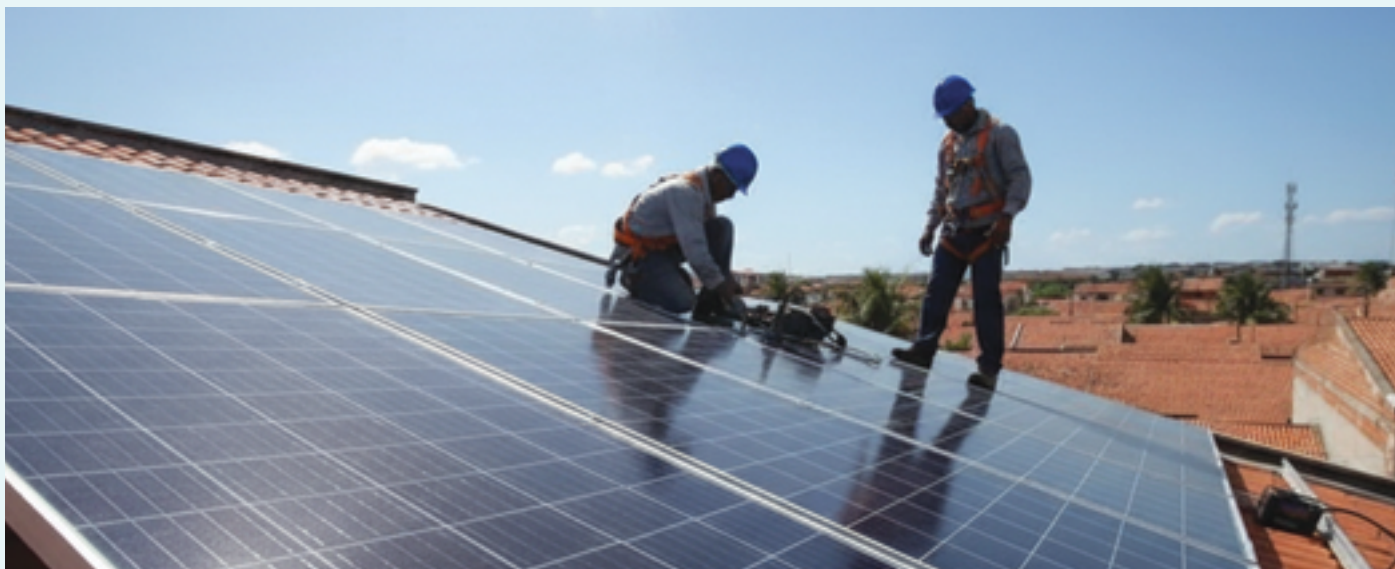
INSTALAÇÃO DE PLACAS SOLARES
