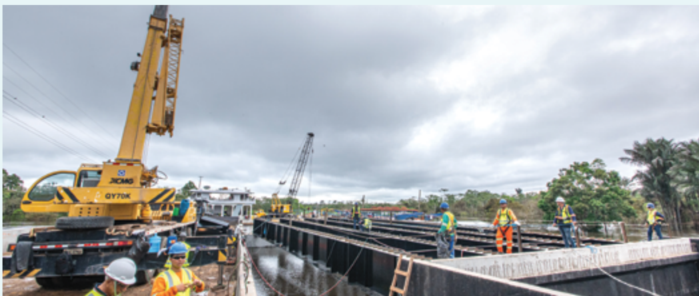
SENADOR EDUARDO BRAGA VISITA OBRAS NA PONTE DO RIO CURUÇÁ – BR-319
